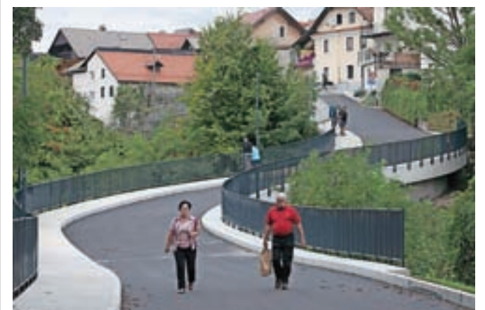
Prenovljeni most nad železnico na poti proti radovljiškemu pokopališču je zdaj širši in omogoča srečevanje dveh osebnih vozil, dodali pa so mu tudi tako imenovani konzolni pločnik. / FOTO: GORAZD KAVČIČ
