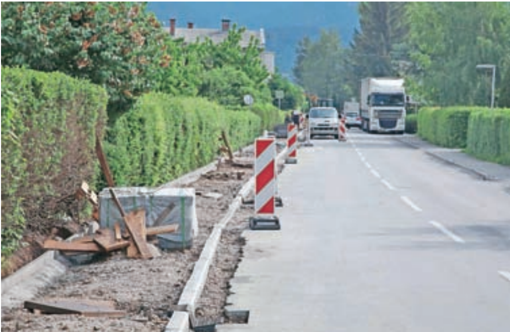
Obnova vodovoda in ceste na Ovsišah in Dobravici / Foto: Gorazd Kavčič
