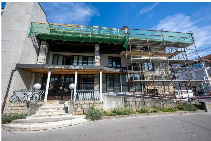
Slika: Obnova strešne kritine na objektu nekdanje knjižnice
